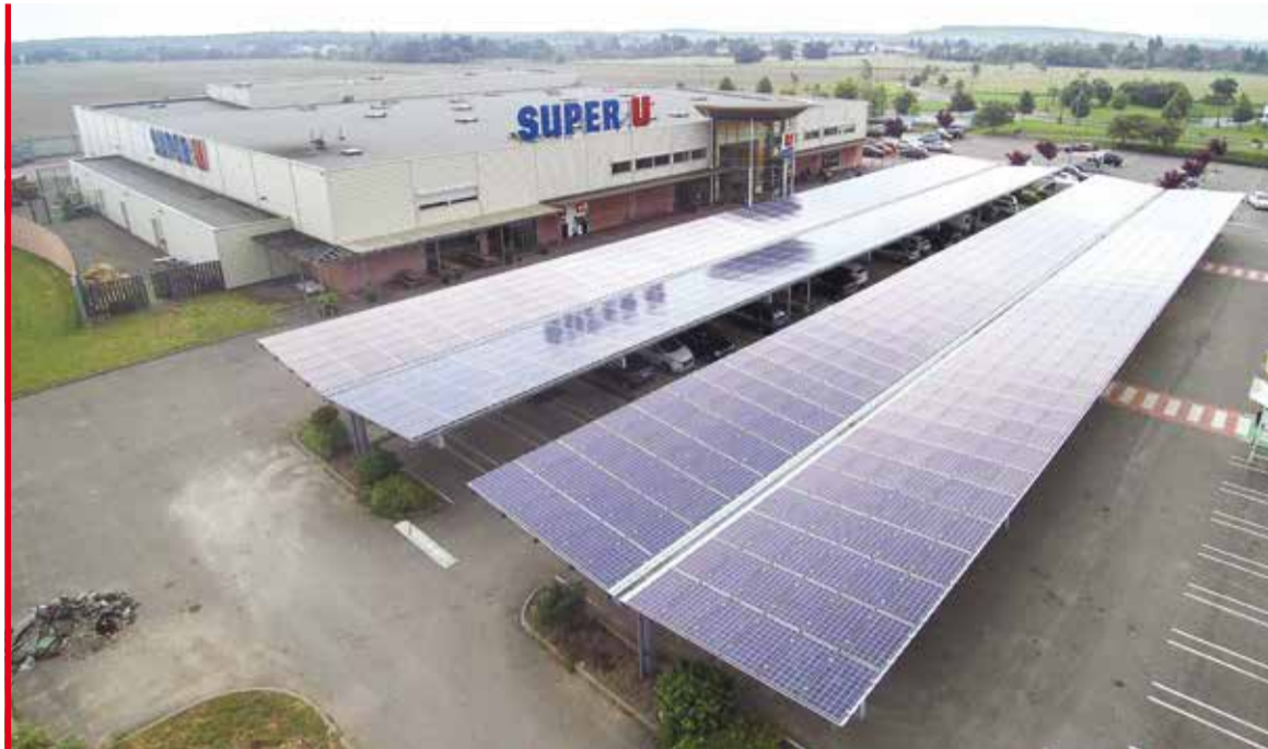
Au-dessus du parking de 150 voitures, les panneaux photovoltaïques permettent de couvrir jusqu'à 17 % des besoins en électricité du Super U de Wittelsheim. © DR
